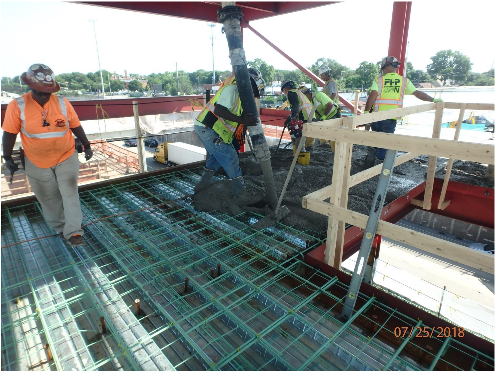
Concrete Pour - North Terminal Second Floor Atrium
